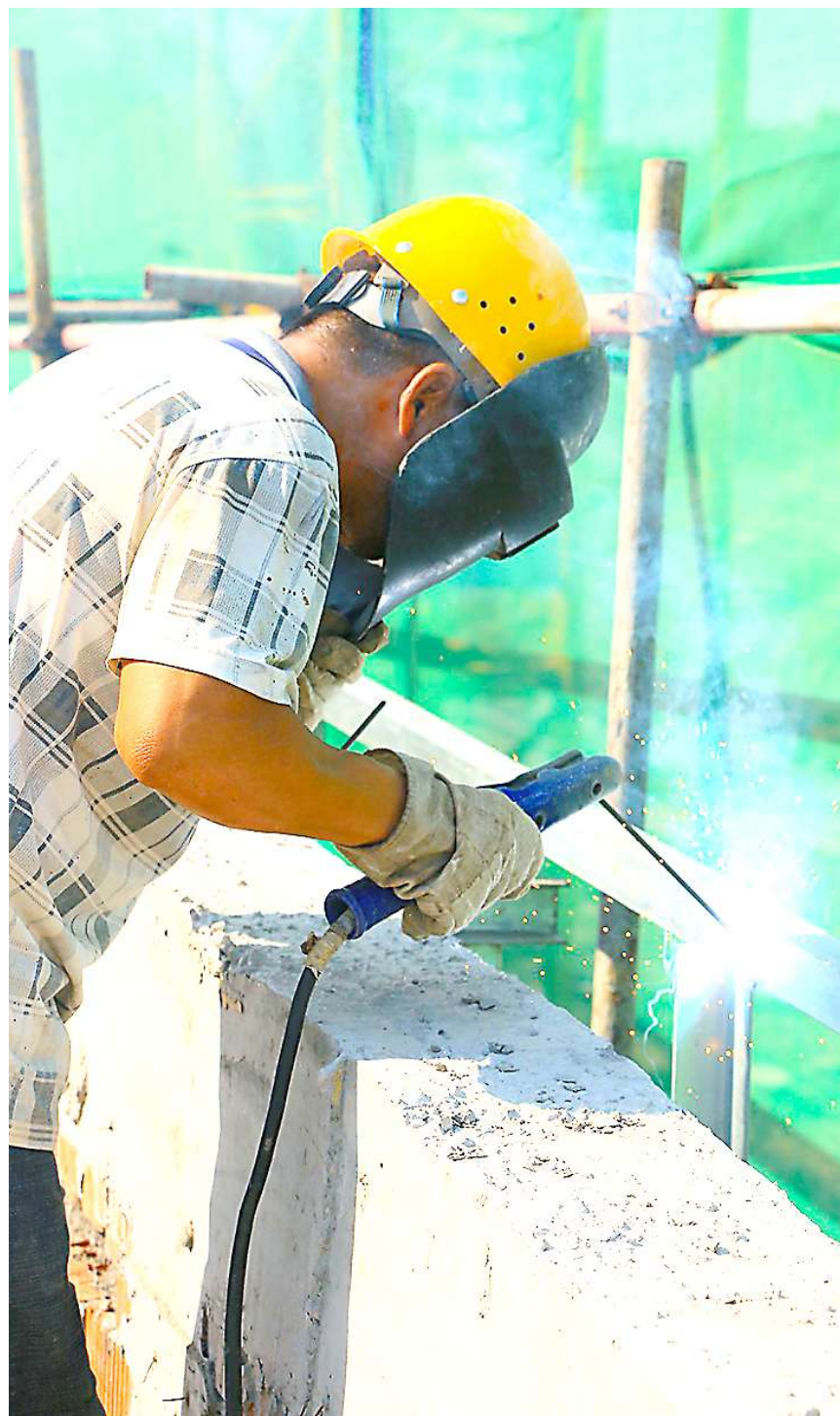
焊工师傅正在对钢筋笼进行加固焊接。
