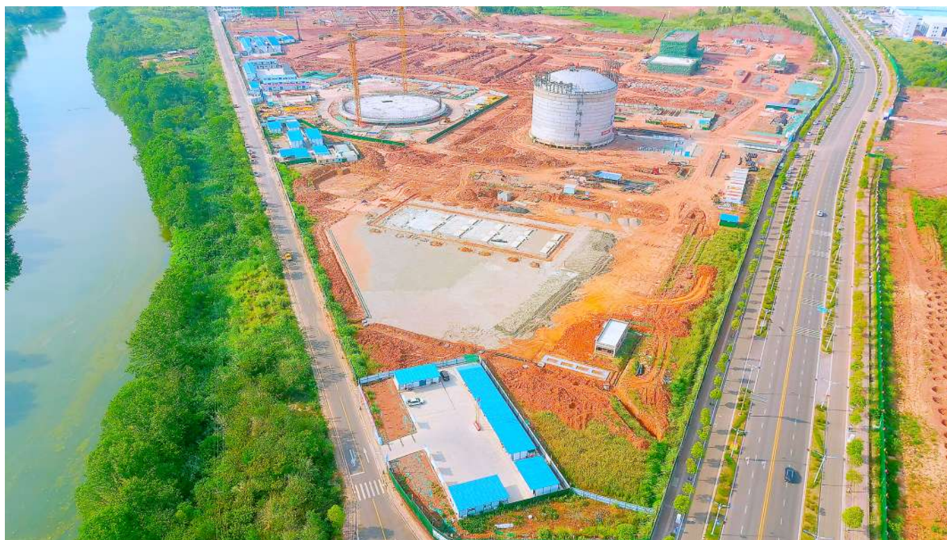
遂宁储气调峰基地项目施工现场。全媒体记者 梁惠摄
