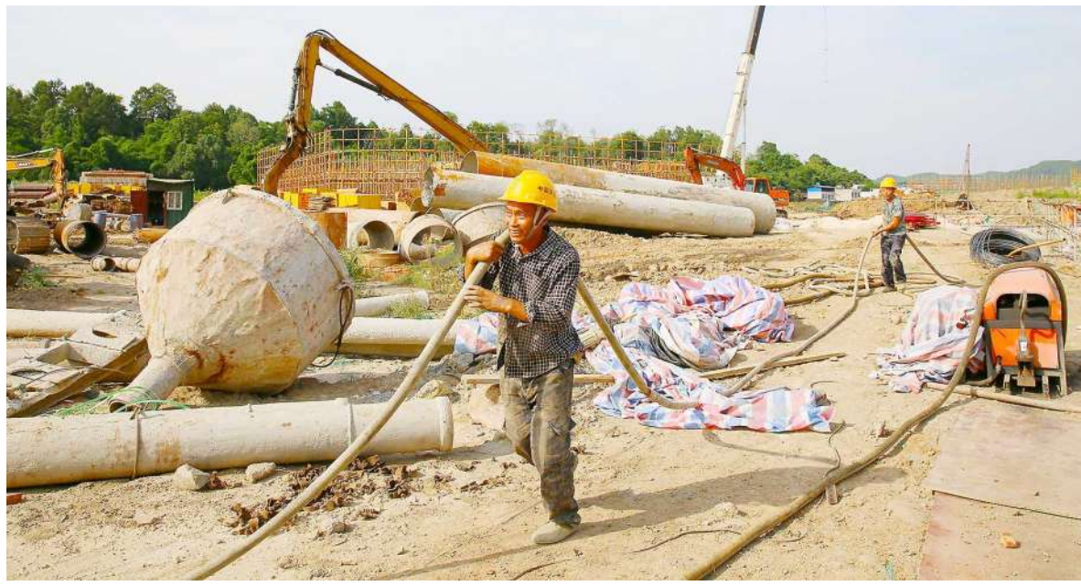
工人们加紧进行锂电学院项目建设。
