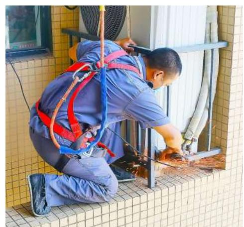
空调安装人员在高温、高空环境下作业。
