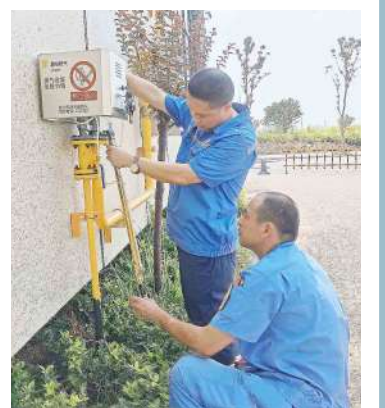
工作人员开展燃气安全隐患排查。
