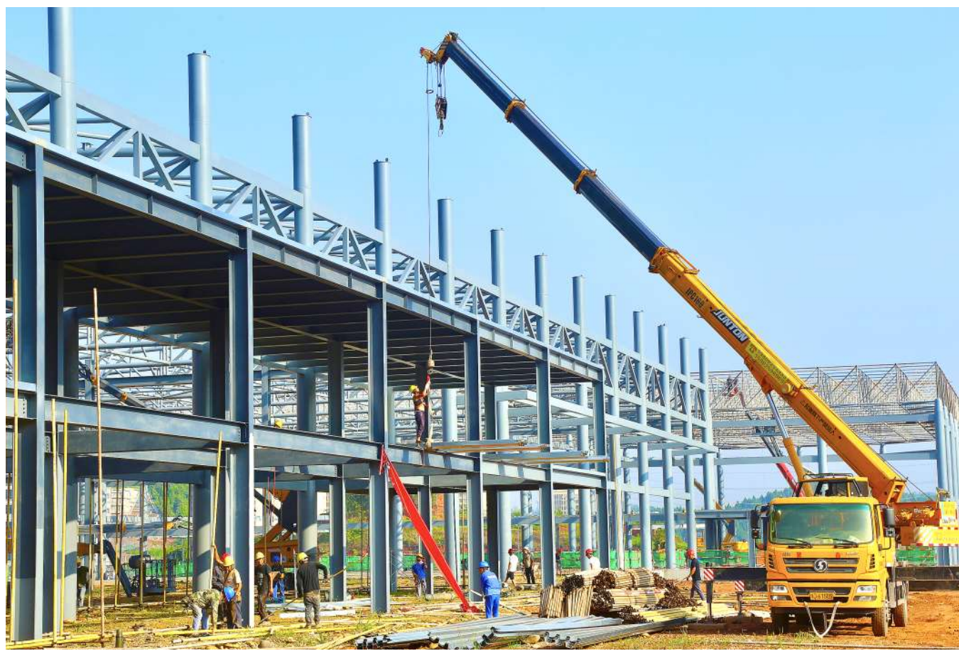
遂宁高新区西部铁路物流园农产品集散中心及配套设施建设项目施工现场。全媒体记者 梁惠 摄
