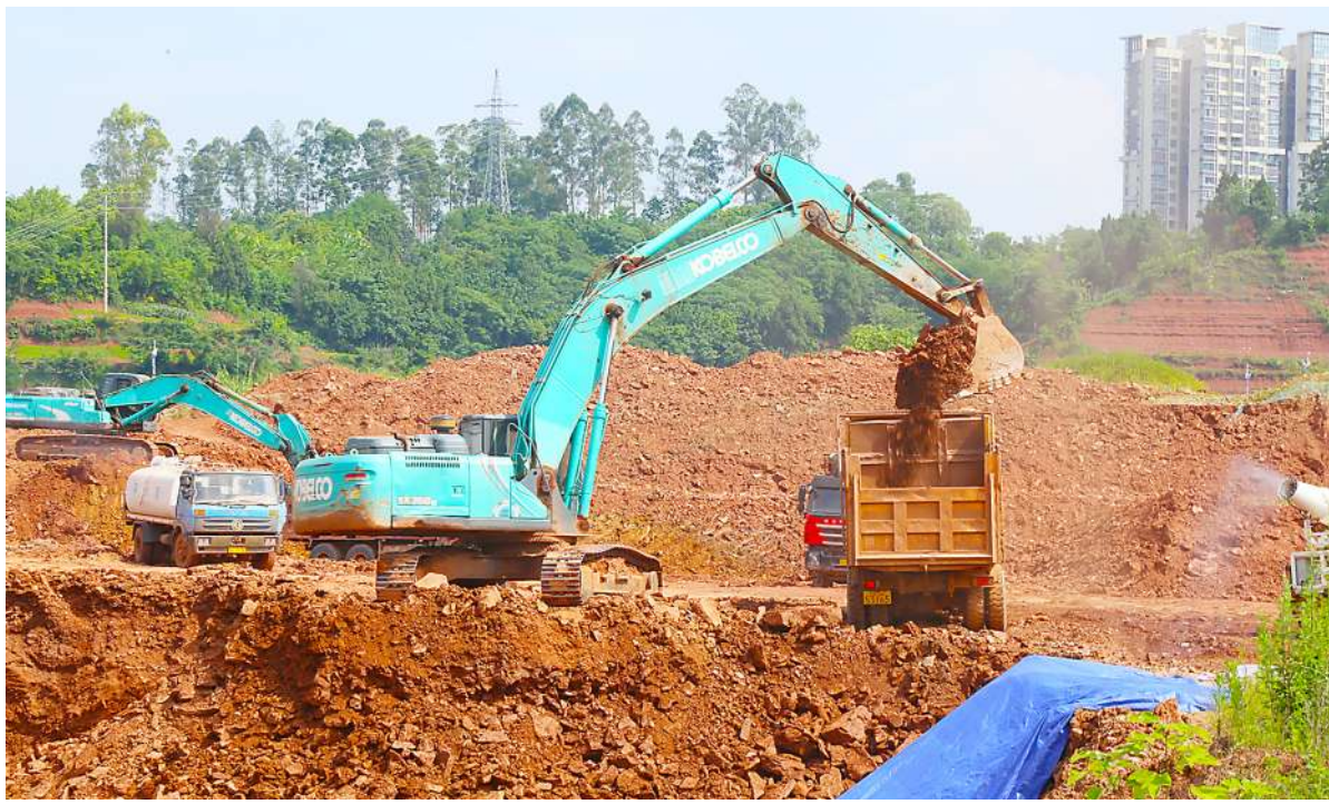
正在施工的桃花山小学项目。
