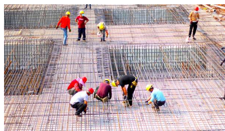
遂宁栖凤智造产业园项目建设现场。
