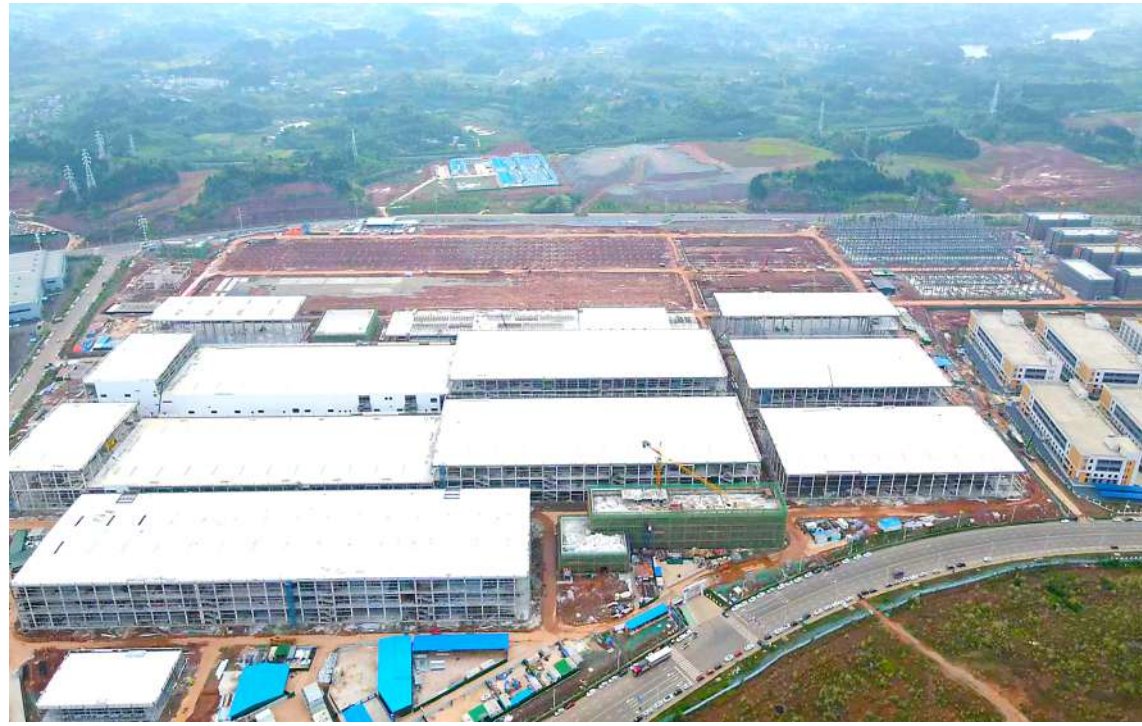
建设中的蜂巢能源项目。
