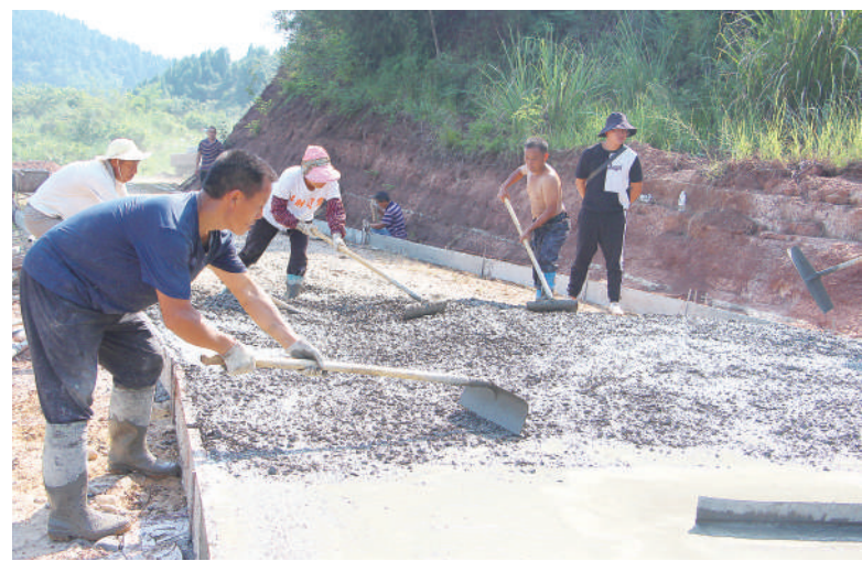
村民们对路面进行混凝土浇筑。
