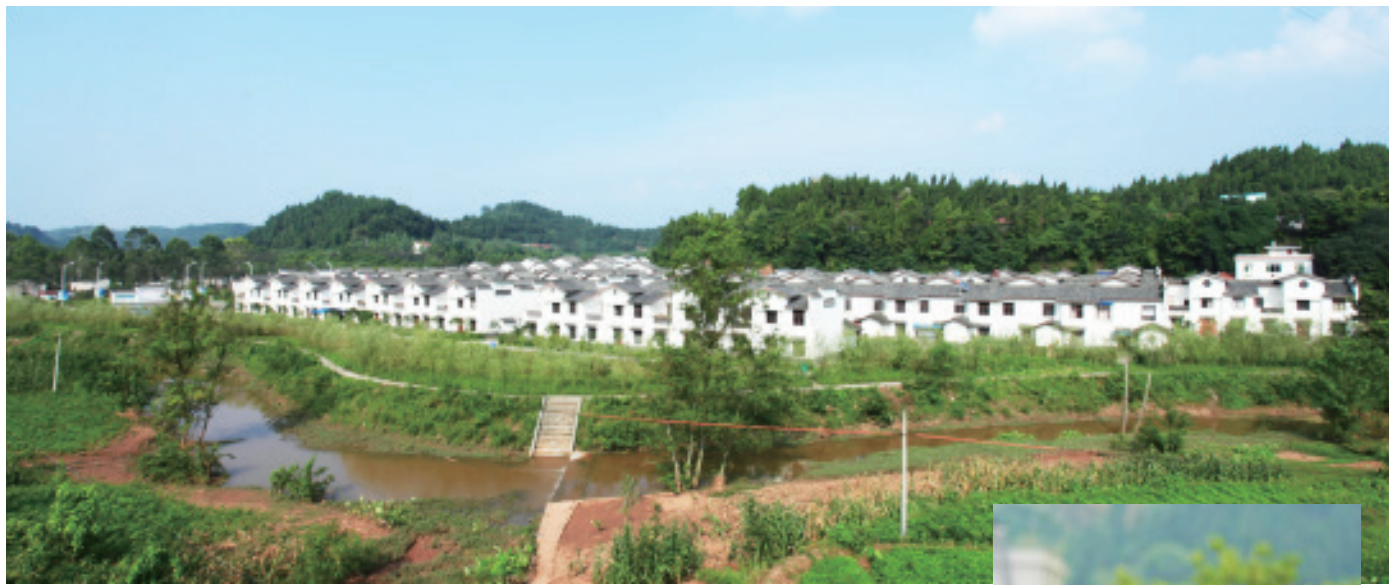
新农村建设（漆家桥桂香小区）
