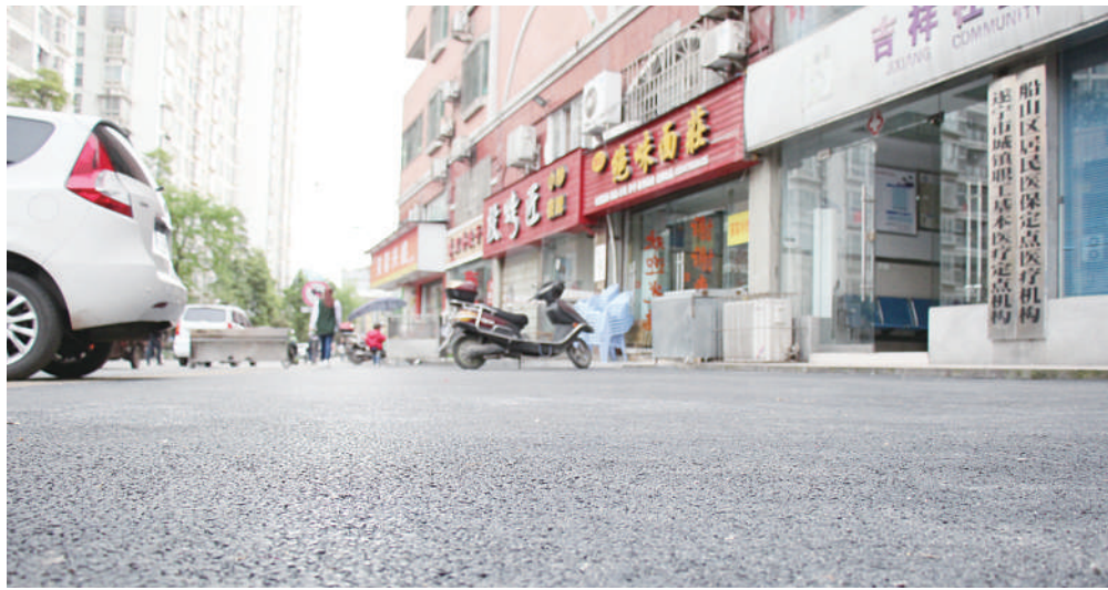
川中大市场海绵城市改造已基本完工
